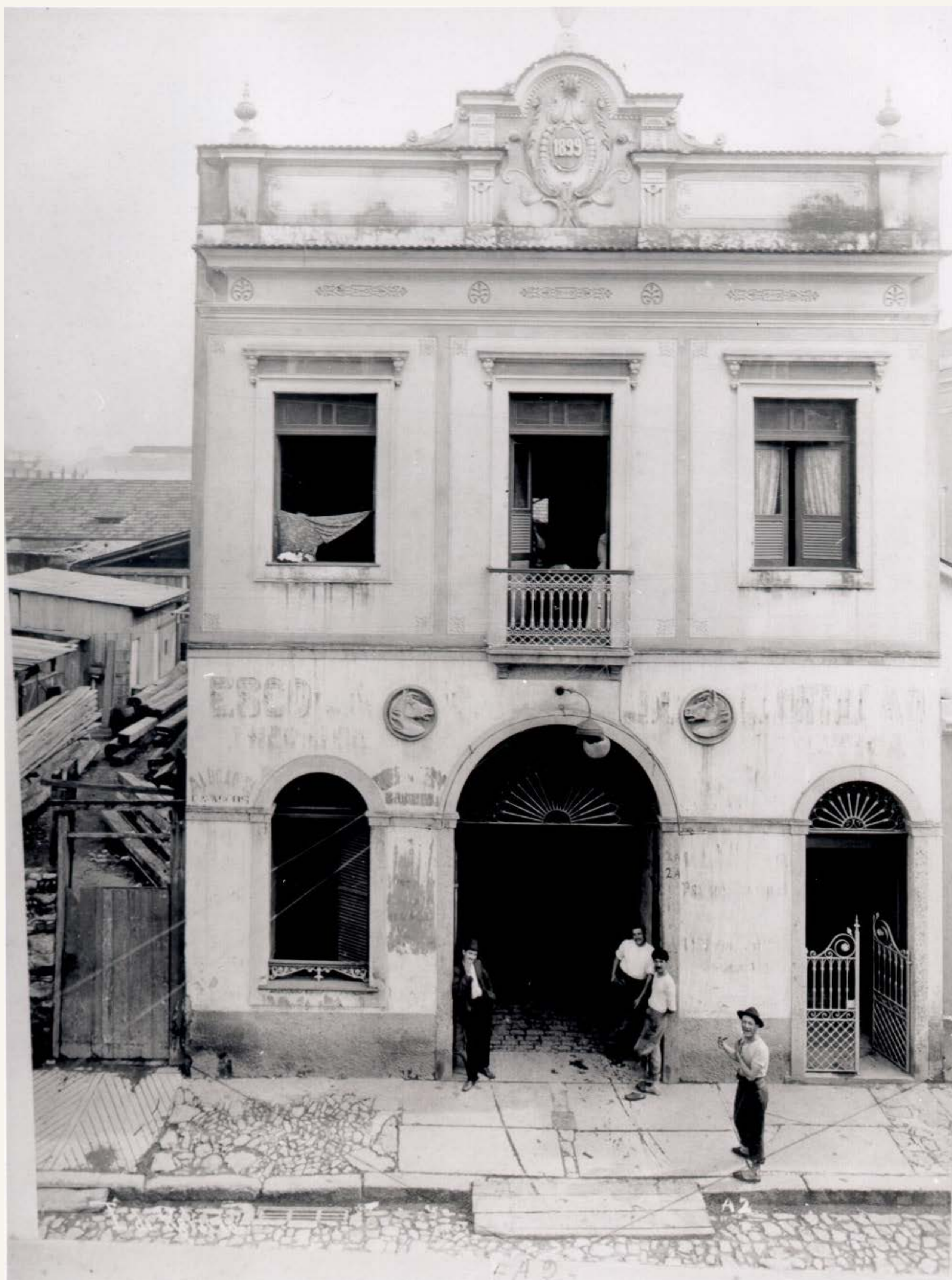
Imagem 19. Fachada de uma habitação coletiva, 1906.
